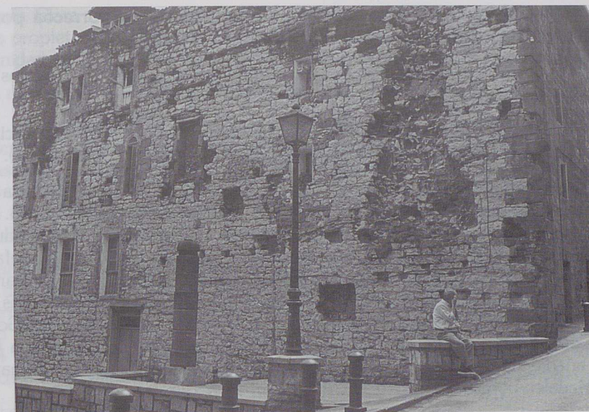
Fotografía nº 3. Fachada Oeste de Torrekoa. Pese a estar muy deteriorada, se advierte su concepción unitaria, y restos de antiguos vanos modificados. (Foto J.M.Leclercq).
